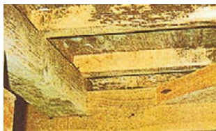
A 床下換気扇を設置していない床下
