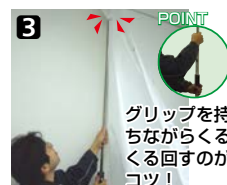
天井に到達したらバーを回転させ、定着するまで微調整します。
