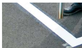
④バーナーで加熱し、溶着する。
