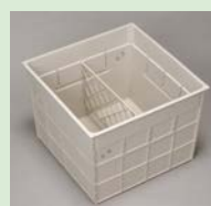
⑤仕切板を入れて完成。
