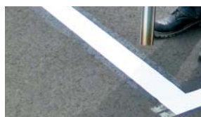
④バーナーで加熱し、溶着する。
