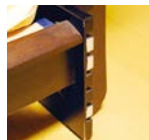
家具などの割れ
