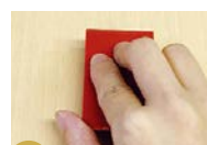
2 ゴシゴシスクレーパーで充填部分を平らにする
