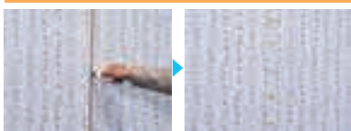
チリや継ぎ目の剥がれは、ビニルクロス補修用ポンド(市販品)で接着。乾燥するまでピンで仮止め。(ドライヤーでの強制乾燥も可能)
